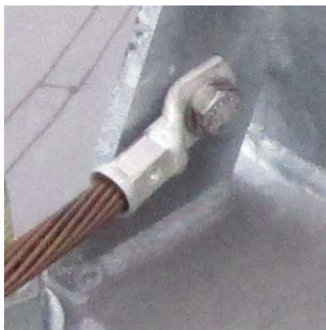
Figur 4: Utførelse av feste av kabelsko på avstiver
