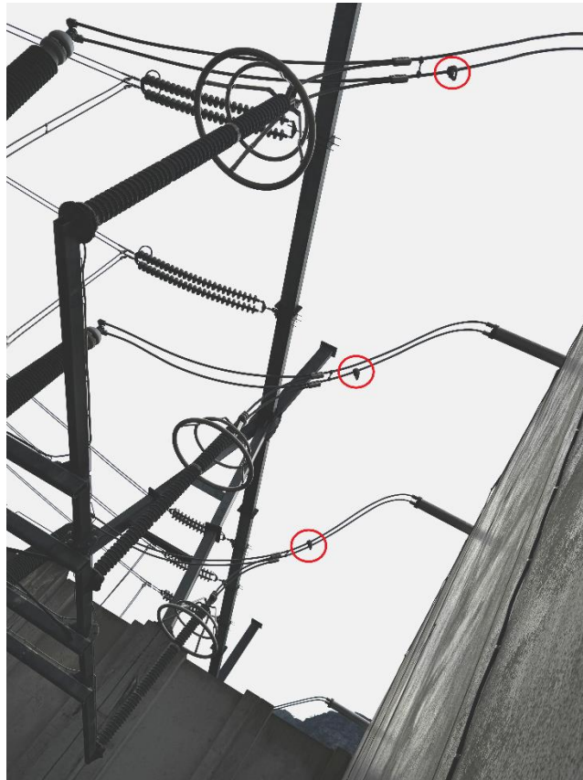
Figur 30: Bøyler for tilkobling av markeringsjord på loop mot transformator
