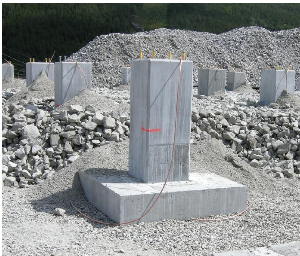
Figur 7: Eksempel på utførelse av fundamentjording
