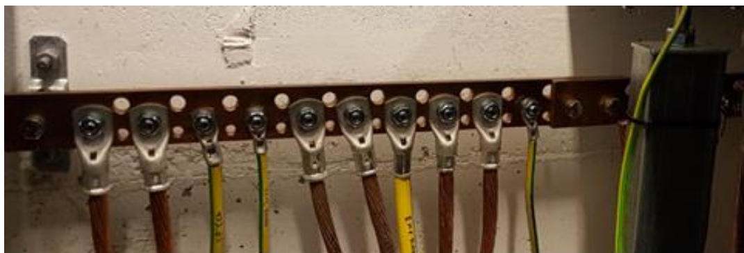
Figur 14: Hovedjordskinne under apparatgulv i fordelingsrom
